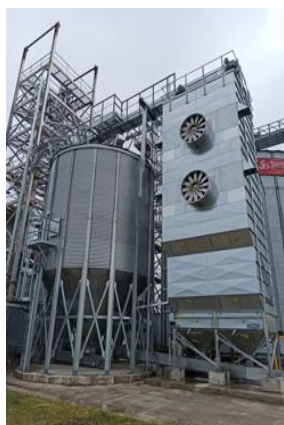
Сушилка 40 тонн в час с линейной горелкой
