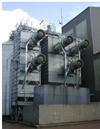
Сушилка 20 тонн в час и сушилка 50 тонн в час с турбоциклонами и шумоподавелями
